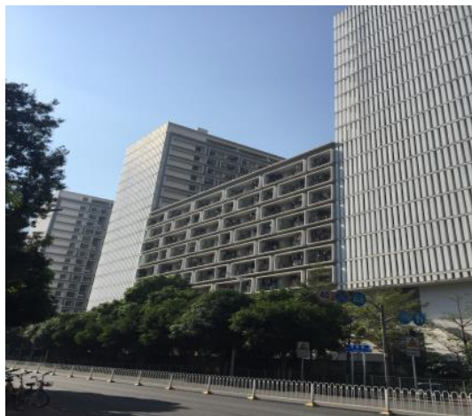
项目西南面深圳大学南校区学生公寓
